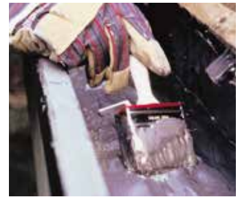
IKO pro Zinkrenovatie
